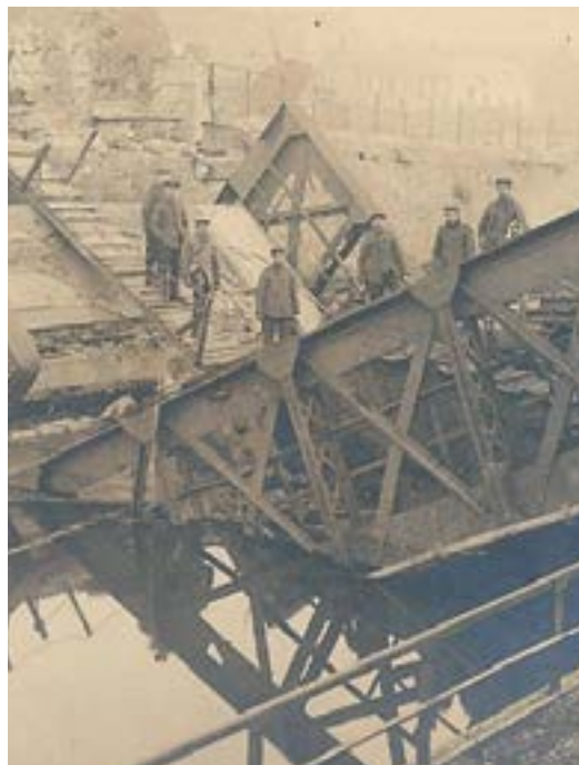
Le pont de Masnières endommagé par les 28 tonnes du tank Flying Fox II | De brug van Masnières beschadigd door de 28 ton van de Flying Fox II | The bridge at Masnières damaged by the 28-tonnes tank Flying Fox II © Philippe Gorczynski
