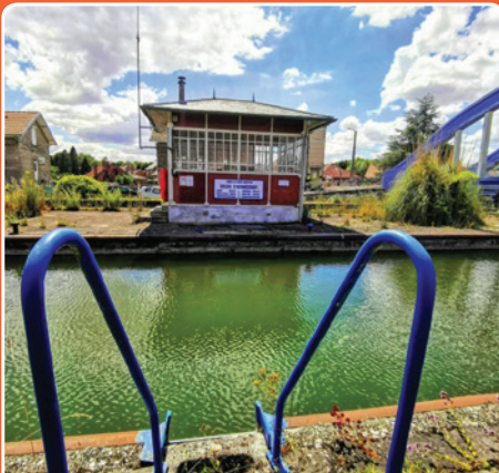
Écluse de Honnecourt-sur-Escaut par @cafou.gnette
