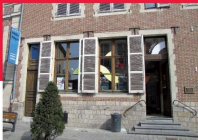
Maison Falleur, 39 rue St-Georges
