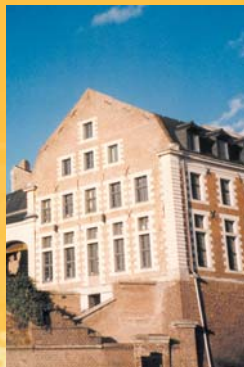
Le château de Selles, du XIII ème siècle, était l'ancienne forteresse des évêques de Cambrai. Il abrite le tribunal.
