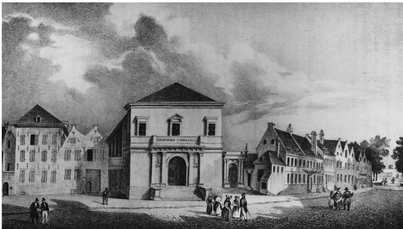
Bibliothèque de l'ancien hôpital Saint-Jean, rue Gambetta XIX e siècle.
